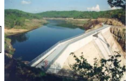
Barrage de la SEP
