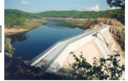
Barrage de la SEP
